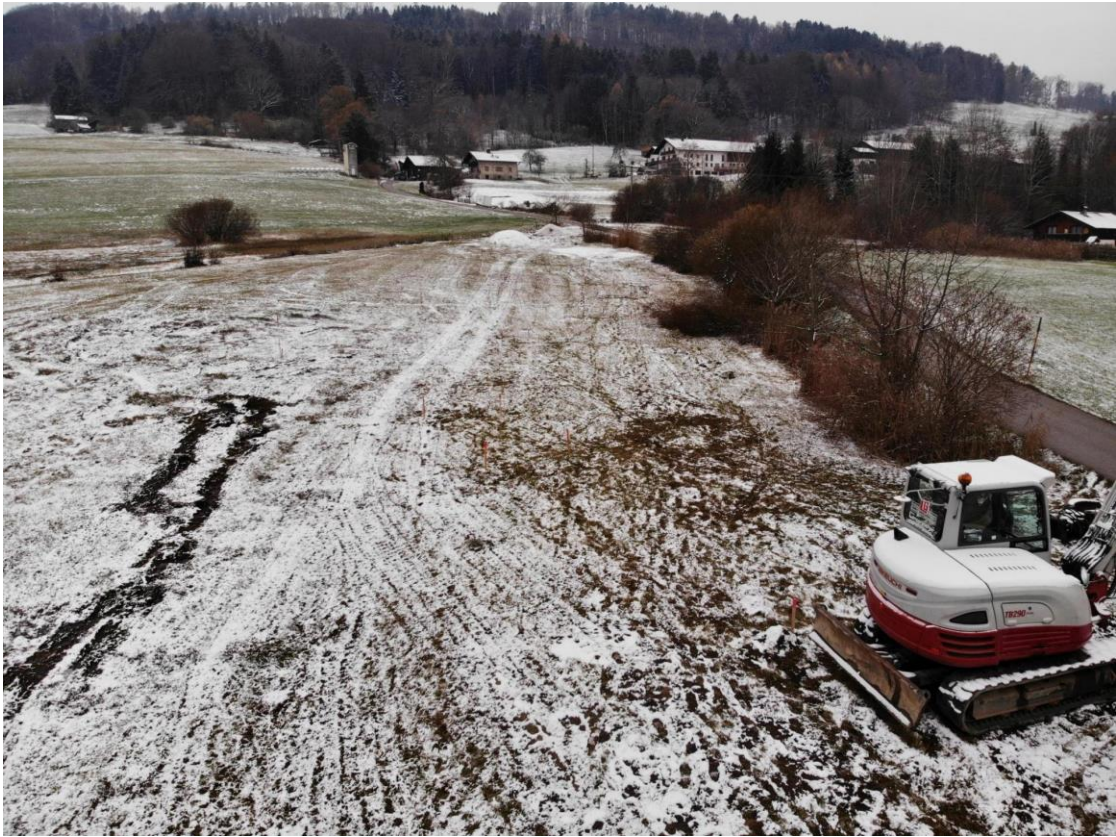
Foto: Parallel zu Straße und Gehölzreihe wird der neue Bachlauf mäandrieren, während der bestehende Bachlauf links im Bild verfüllt wird. (Foto: WWA Traunstein, Seiwald)
